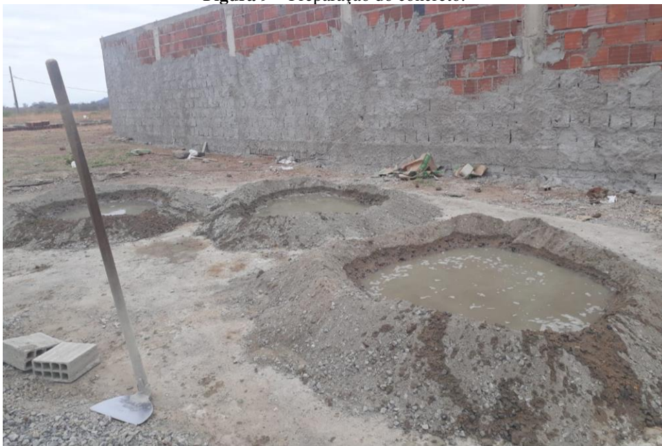
Figura 9 – Preparação do concreto.
