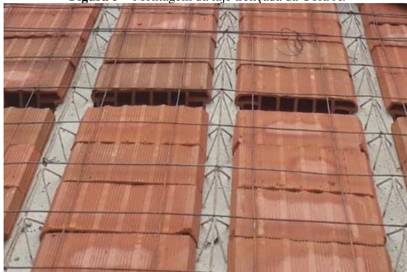
Figura 5 – Montagem da laje treliçada da Obra A.
