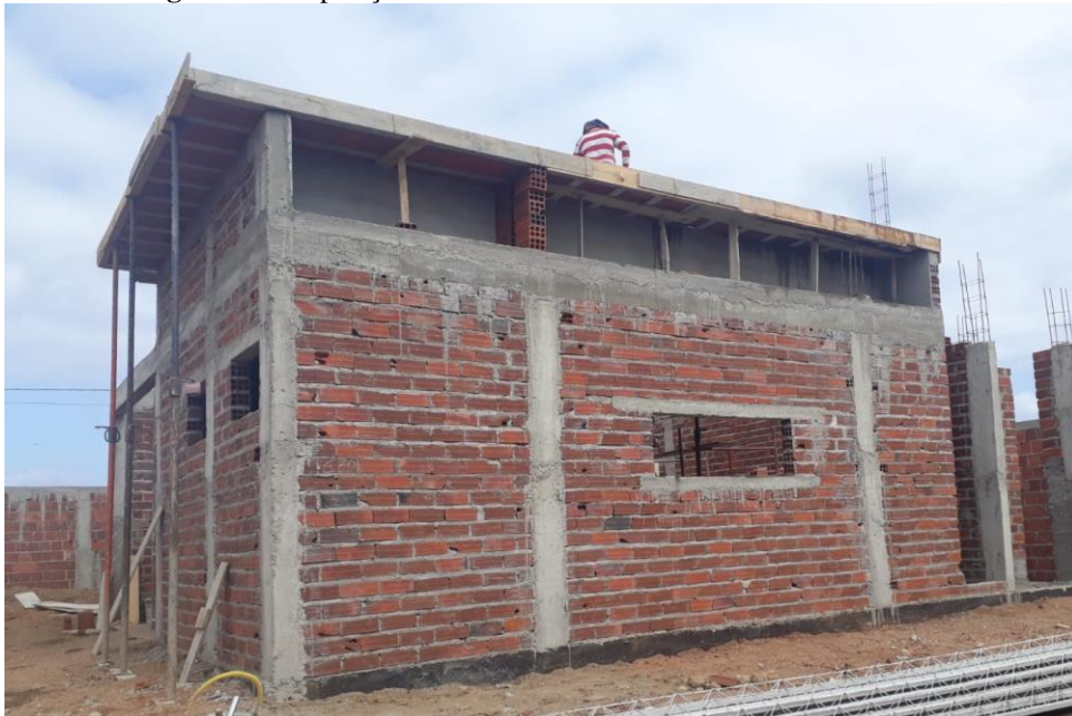
Figura 6 – Disposição das escoras de madeira e de bloco cerâmico.
