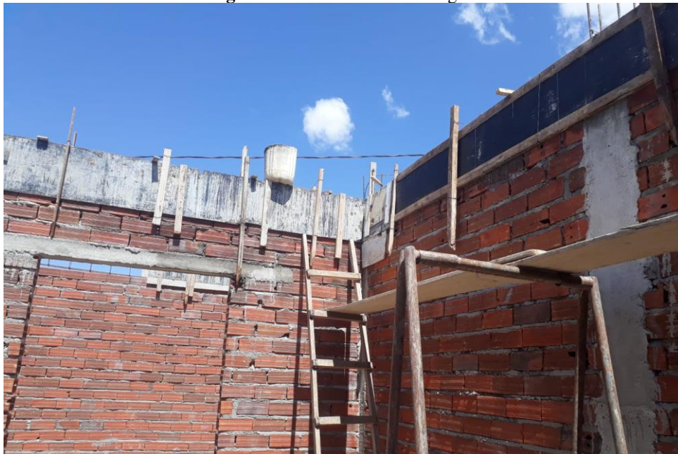
Figura 16 – Abafamento das vigas.
