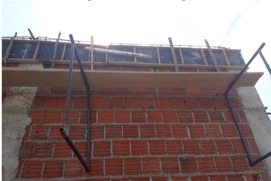
Figura 22 – Abafamento das vigas.
