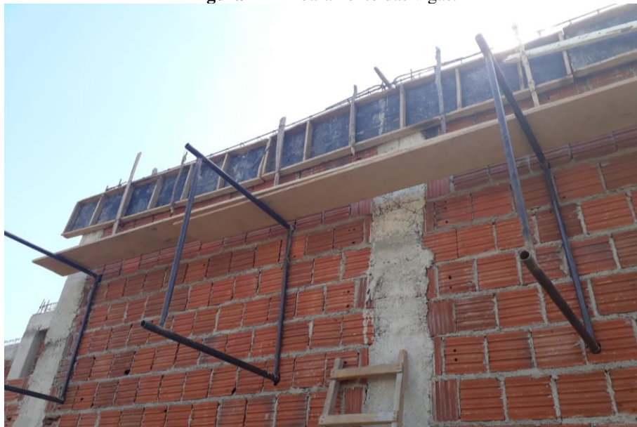
Figura 21 – Abafamento das vigas.
