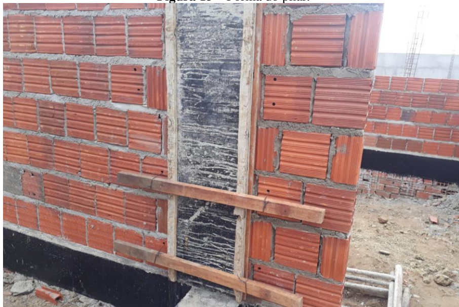
Figura 15 – Fôrma do pilar.
