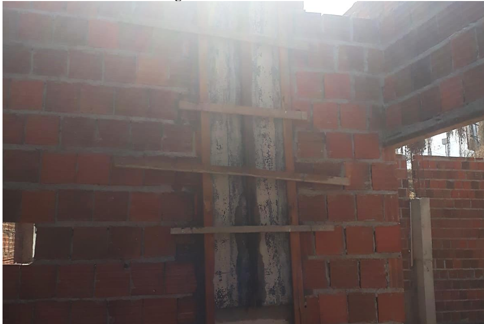
Figura 10 – Fôrma da coluna.
