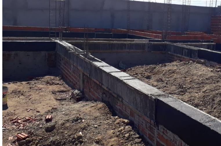
Figura 14 – Concretagem das vigas baldrame.
