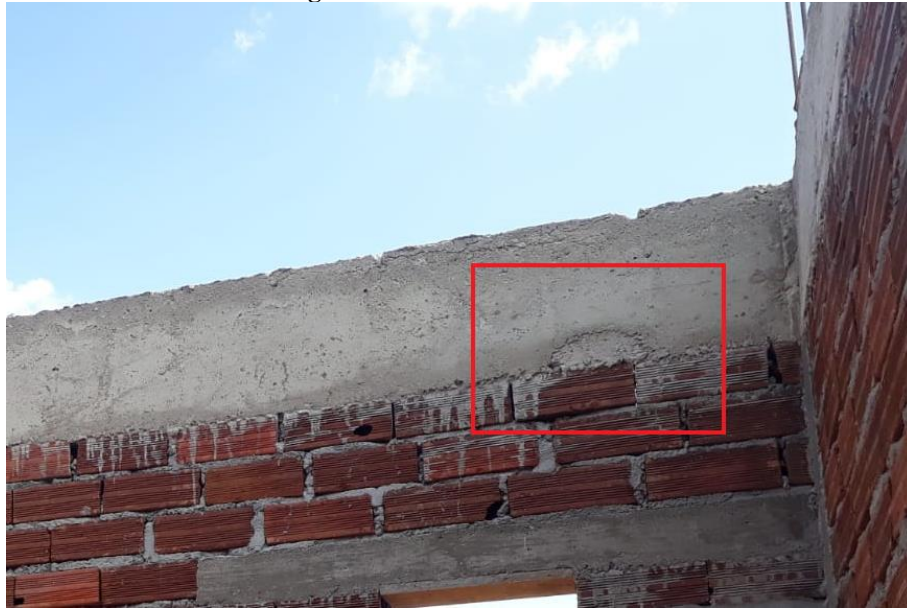
Figura 17 – Concreto destacado.
