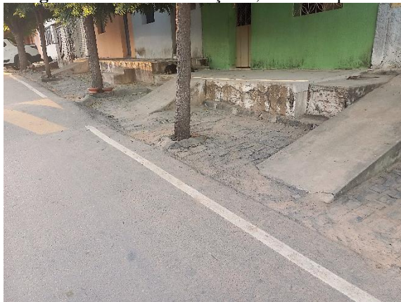
Figura 6 – Altura das calçadas, lateral esquerda.
