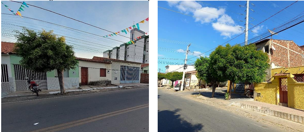
Figura 4 – Galhos de árvore ultrapassando fios elétricos, lateral direita.
