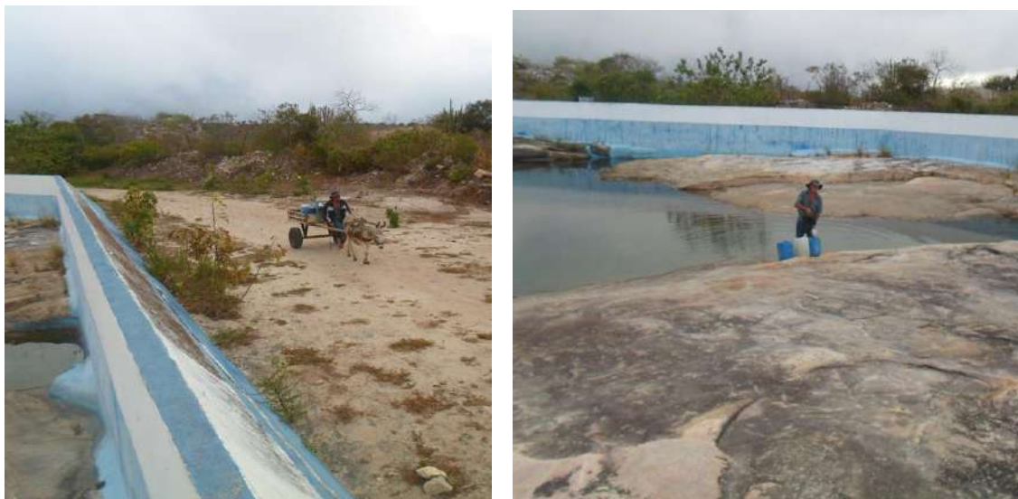
Figura 3 - Morador retirando água do Tanque do Arroz
