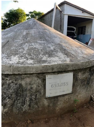
Figura 5 - Cisterna com placa de identificação.
