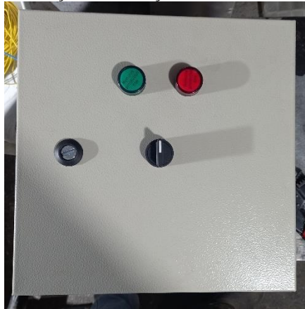
Figura 53 – Furação e Colocação de Comando e Sinalização
