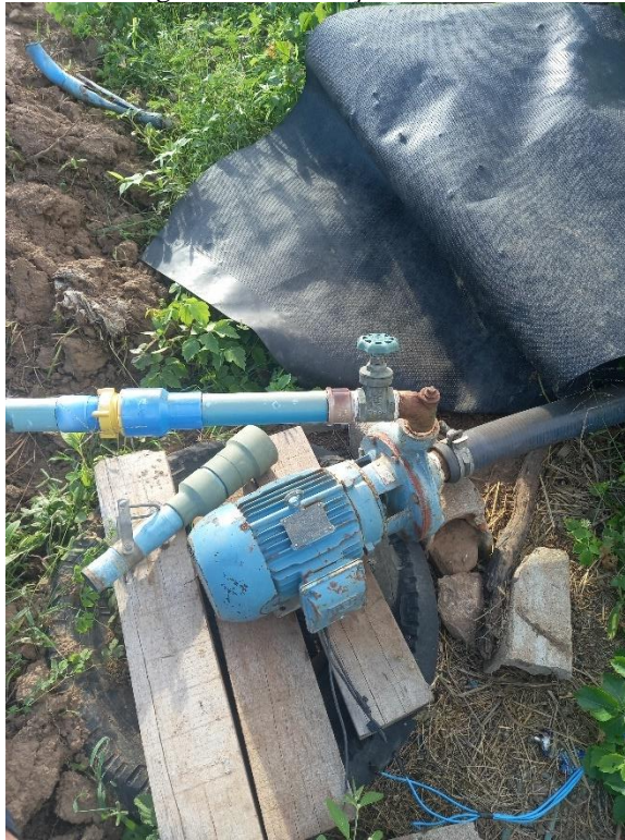
Figura 29 – Instalação do Motor
