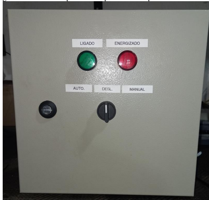
Figura 57 – Identificação das Funções dos Componentes de Comando
