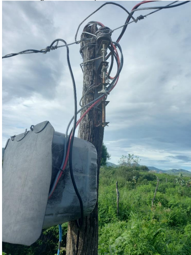
Figura 28 – Derivação da Rede Trifásica
