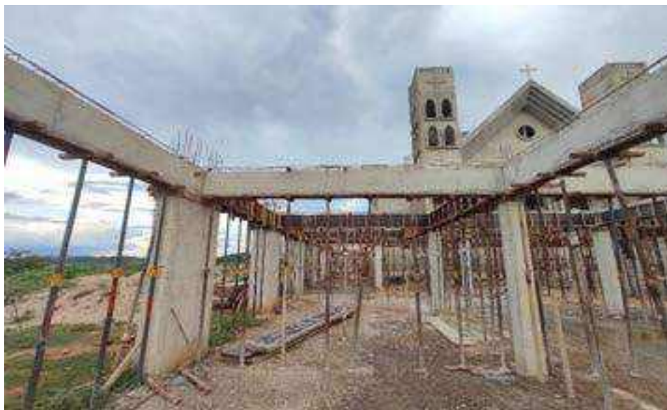
Figura 9 - Execução de vigas
