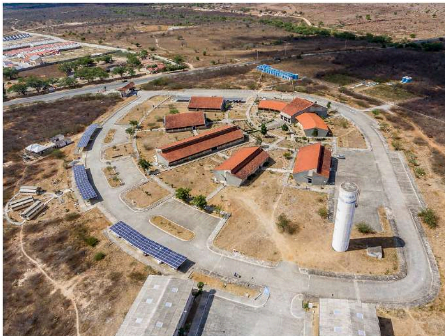
Figura 15: Área do INSA - Complexo Administrativo (Sede). Fonte: INSA, 2022.
