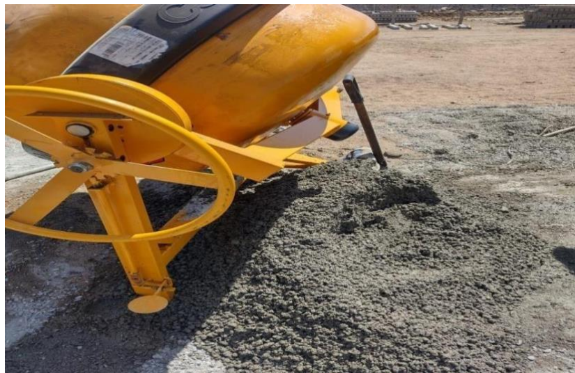
Figura 6- Mistura em betoneira do concreto utilizado para fabricação das estacas
