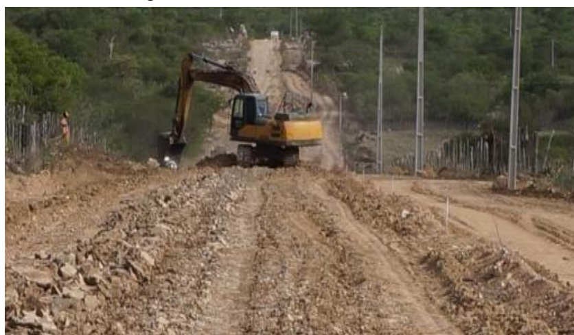
Figura 12 – Corte com retroescavadeira
