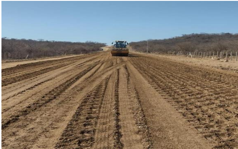
Figura 15 – Compactação da sub-base
