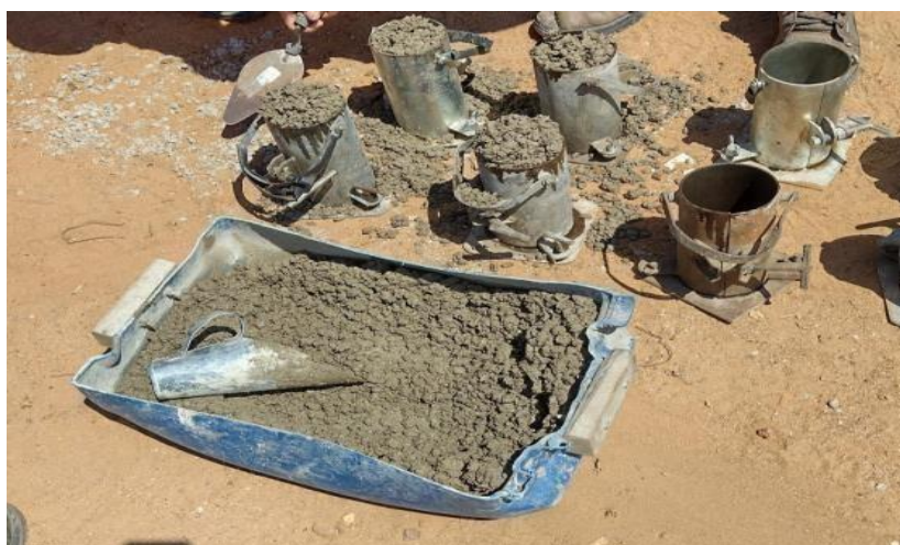
Figura 7 – Moldagem dos corpos de prova para ensaio de resistência à compressão
