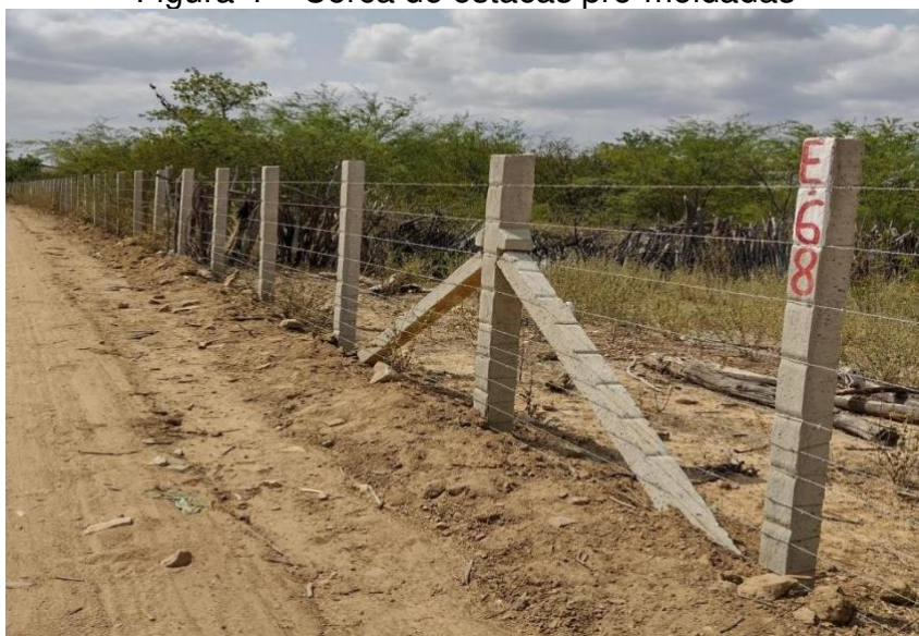
Figura 4 – Cerca de estacas pré-moldadas
