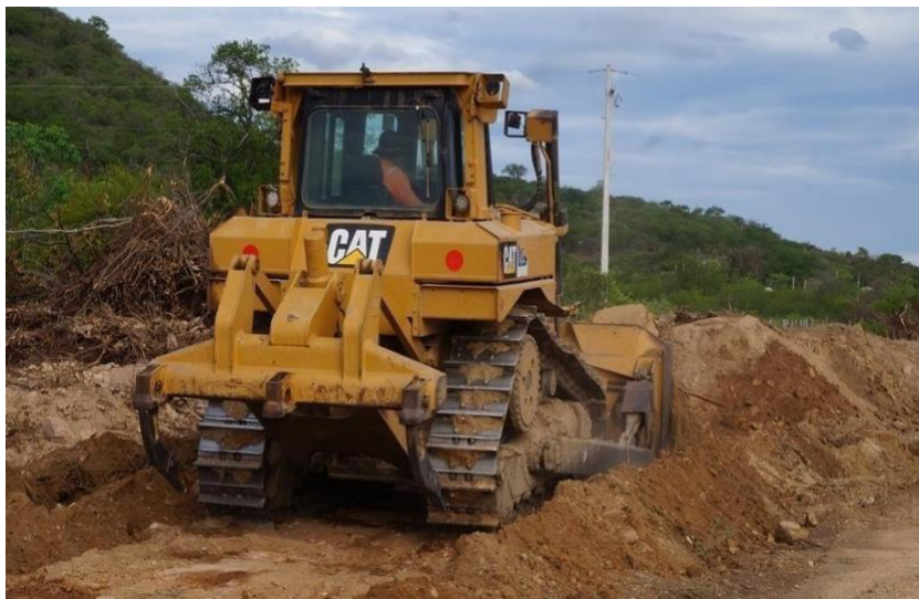
Figura 10 – Material para aterro
