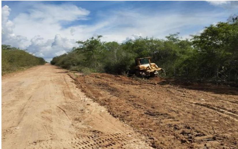
Figura 9 – Limpeza e desmatamento
