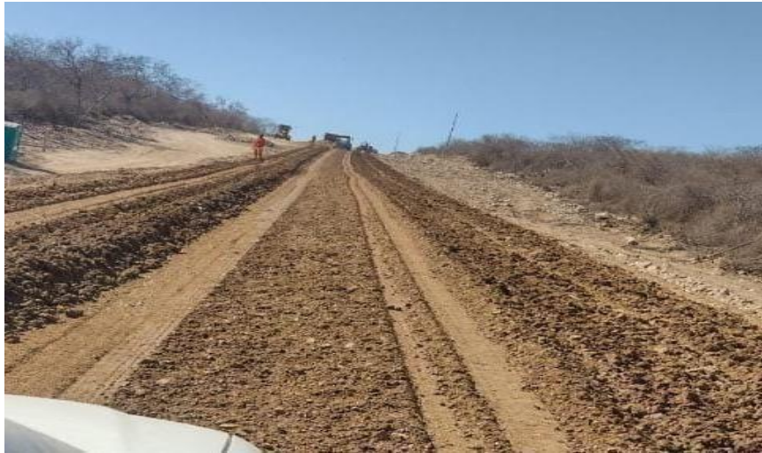
Figura 13 – Escarificação das camadas do solo
