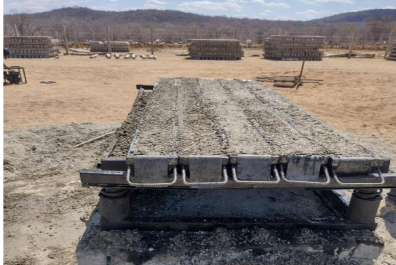
Figura 5 – Adensamento do concreto das estacas em mesa vibradora
