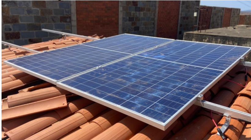
Figura 51 - Módulos fotovoltaicos fixados.
