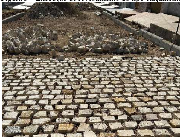
Figura 5 – Execução de revestimento do tipo calçamento.
