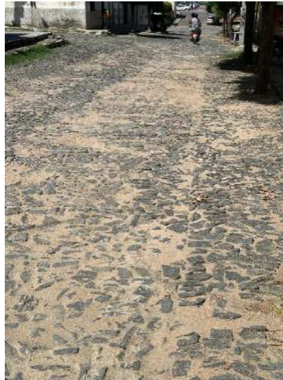
Figura 4 – Revestimento de alvenaria poliédrica.
