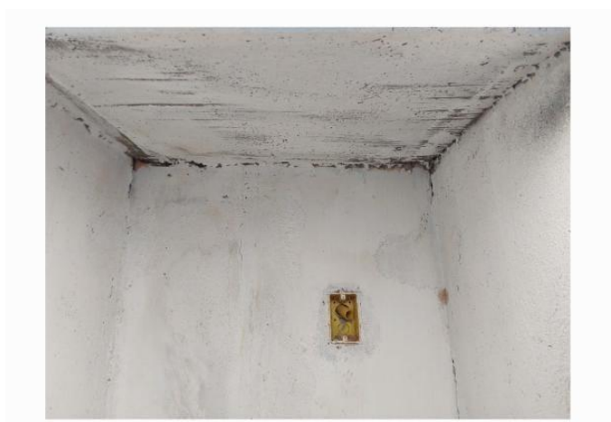
Figura 10 – Tomada do compressor
