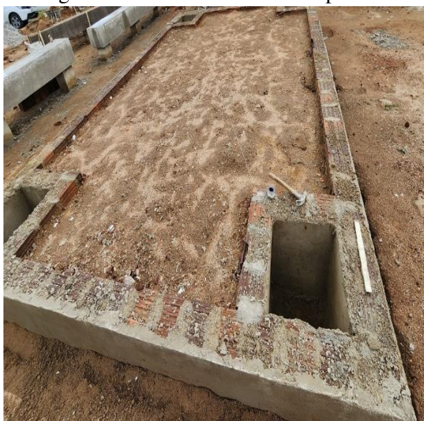
Figura 8 - Linha-Guia Para Compactar
