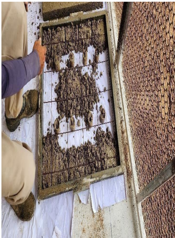
Figura 13 - Confeção Tampas De Concreto
