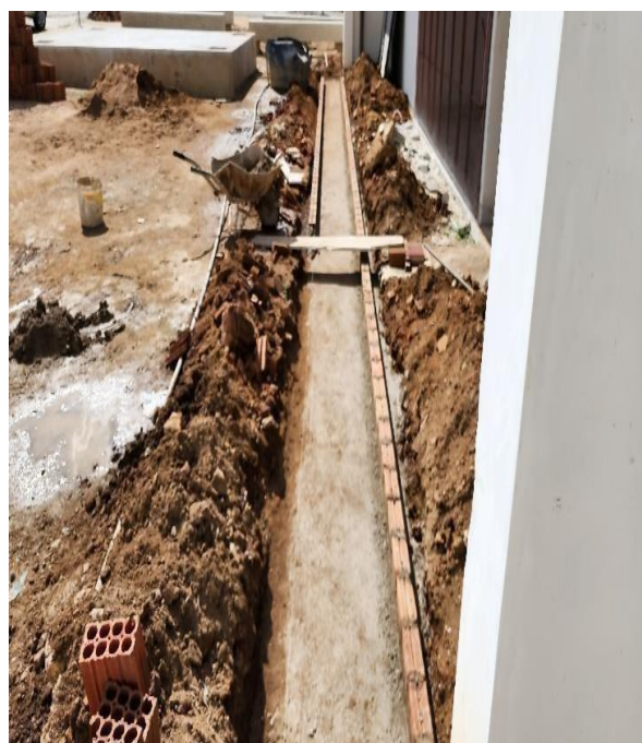
Figura 11 - Assentamento Dos Tijolos
