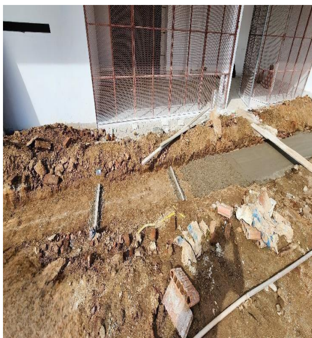
Figura 10 - Mechar Para Contrapiso Da Calha
