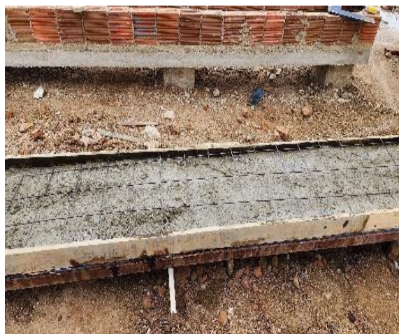
Figura 4 - Malha De Ferro
