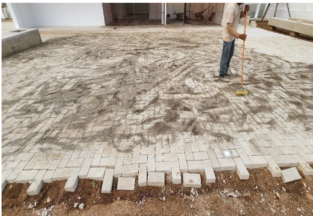
Figura 19 - Rejuntamento Com Vassoura
