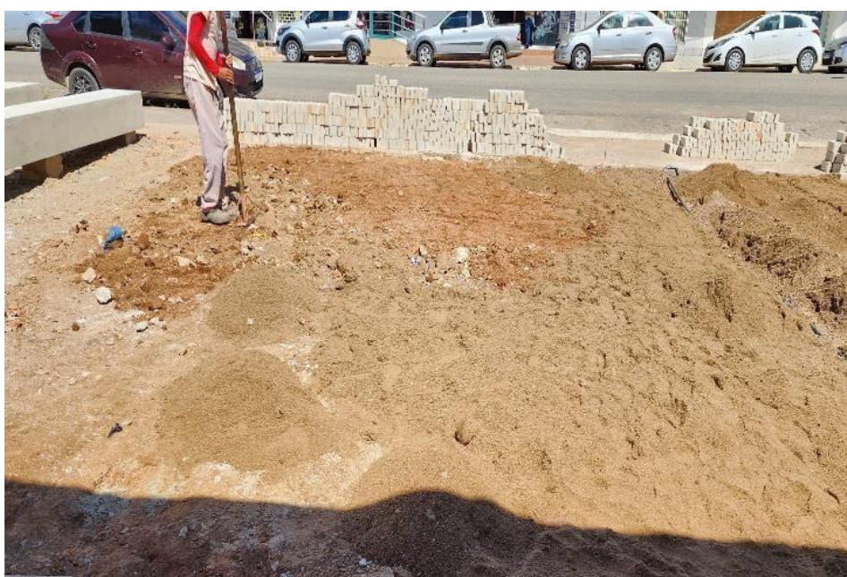
Figura 18 - Compactação da Area
