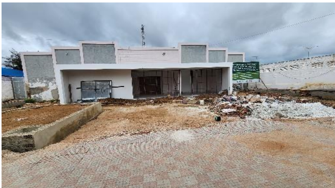
Figura 1 – Obra em andamento
