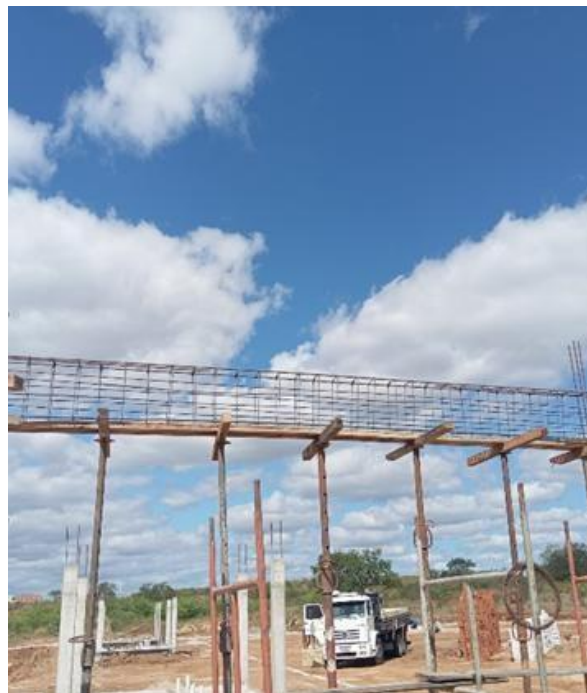
Figura 8 – Colocação das armaduras
