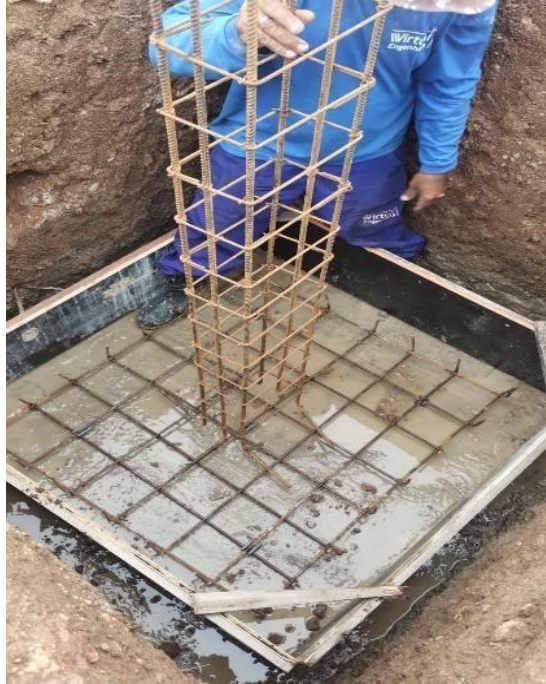
Figura 6 - Colocação de Armação e Fôrmas.
