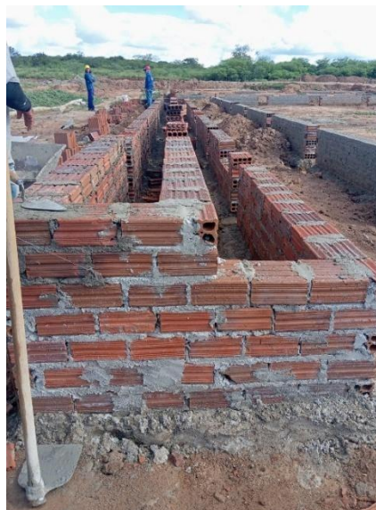
Figura 12 – Execução de alvenaria da arquibancada.
