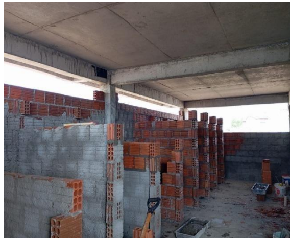
Figura 11 – Execução de alvenaria do camarote.
