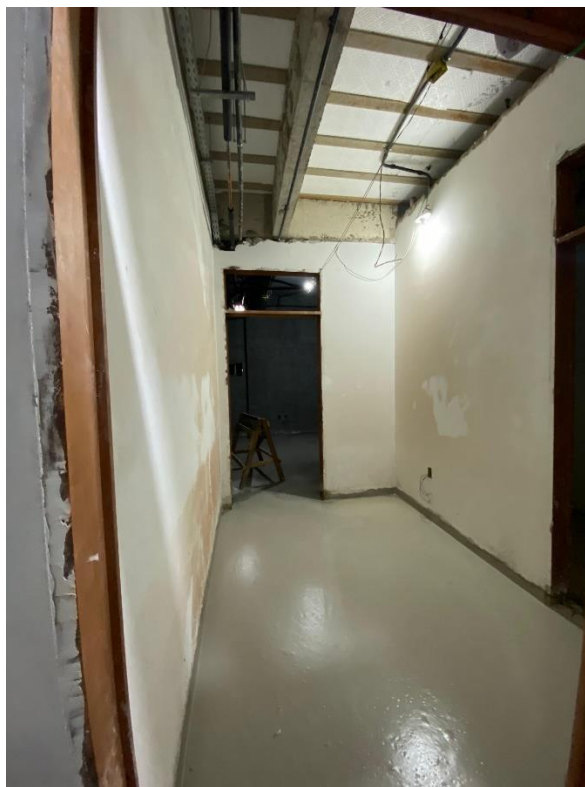
Figura 11 – Piso com o primeiro processo de polimento concluído.
