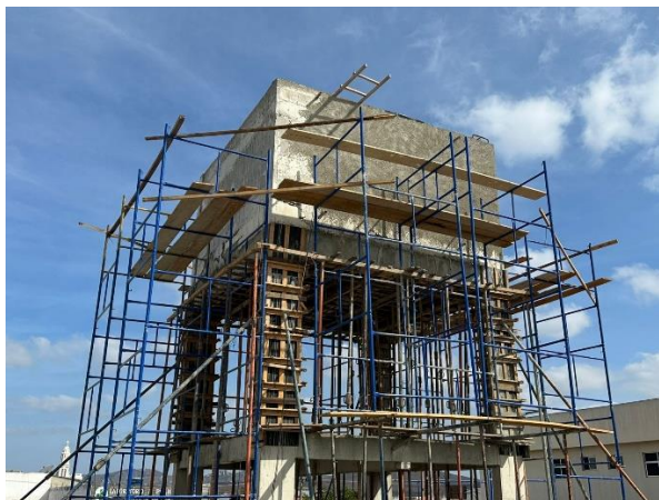
Figura 4 - Segunda laje, paredes estruturais e terceira laje concretadas ao término do estágio.
