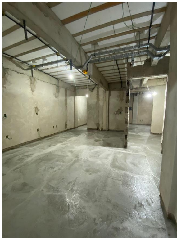
Figura 10 – Piso em processo de cura.
