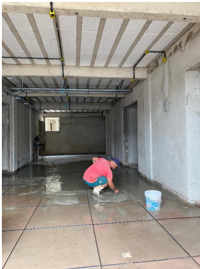
Figura 9 – Aplicação da base cimentícia sobre o contrapiso.
