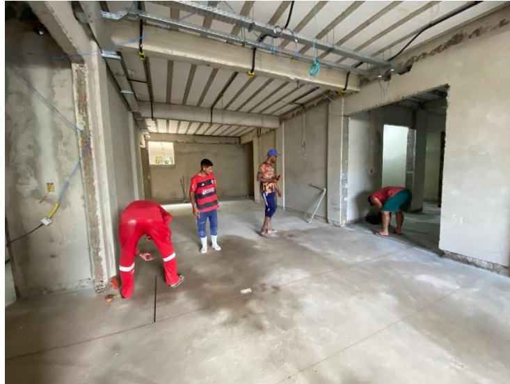
Figura 6 – Marcações e aplicação das juntas no contrapiso.
