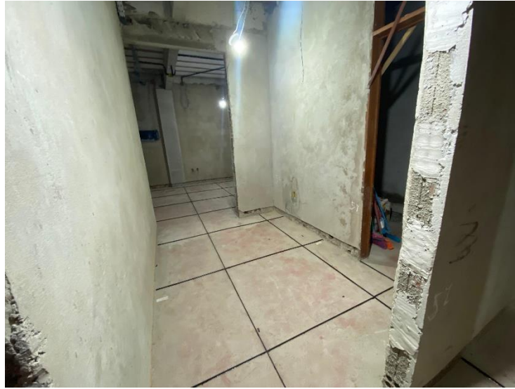
Figura 7 – Fixação das juntas no contrapiso.
