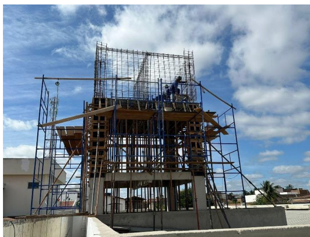
Figura 3 - Instalação das cortinas de ferro no reservatório de água.
