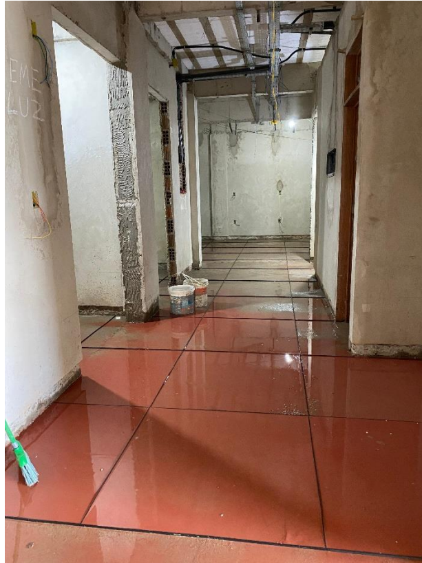
Figura 8 – Etapa de limpeza para a remoção de resíduos restantes após a aplicação das juntas.
