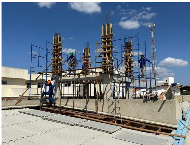
Figura 1 - Caixa d'água em construção no topo do hospital, com colunas e vigas em andamento.
