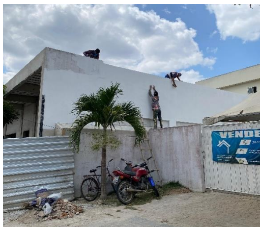
Figura 15 – Acabamento das paredes externas.
