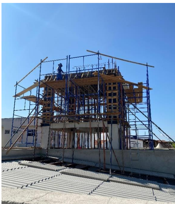
Figura 2 - Execução da segunda laje da caixa d'água, com fôrmas instaladas, em 19 de setembro.
