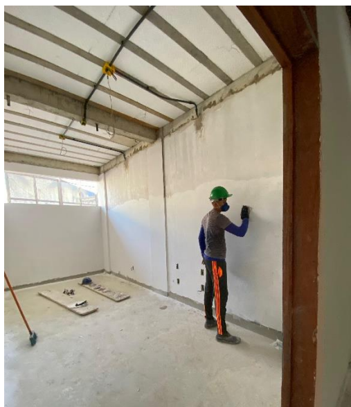
Figura 14 – Lixamento das paredes internas.
