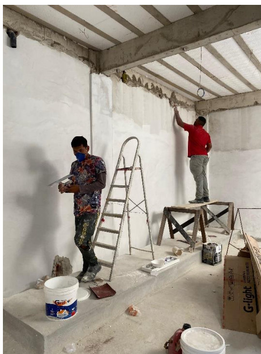
Figura 13 – Aplicação de massa corrida nas paredes internas.
