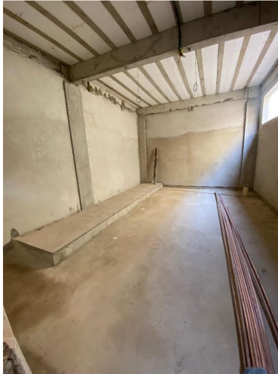
Figura 5 - Contrapiso concluído, aguardando a instalação do piso de granilite.
