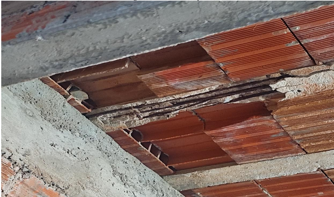
Figura 9 - Carbonatação.
