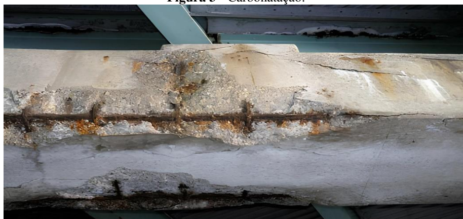
Figura 3 - Carbonatação.
