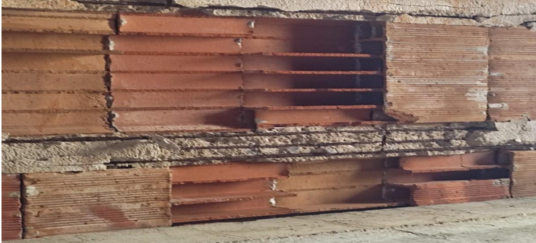
Figura 11 - Corrosão do aço.
