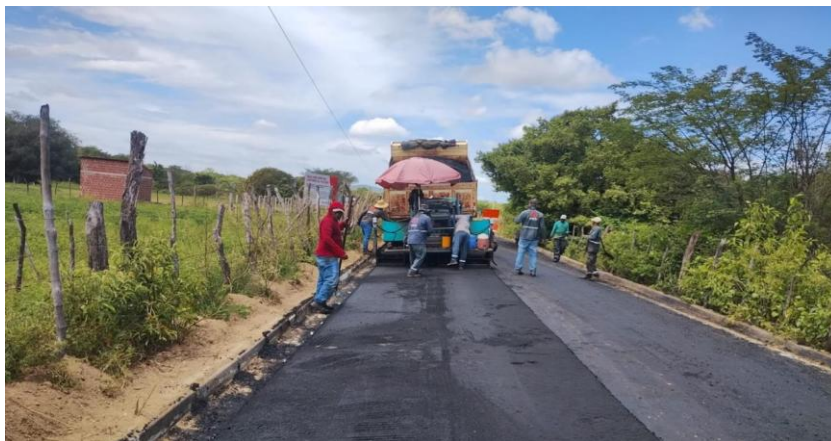
Figura 2: Registro de uma usina de asfalto em produção, mistura asfáltica desenvolvida para suportar o tráfego intenso.
