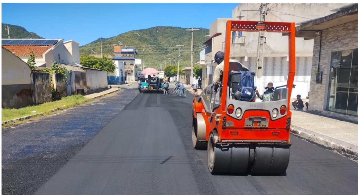
Figura 6: Pavimento Flexível em rodovia.
