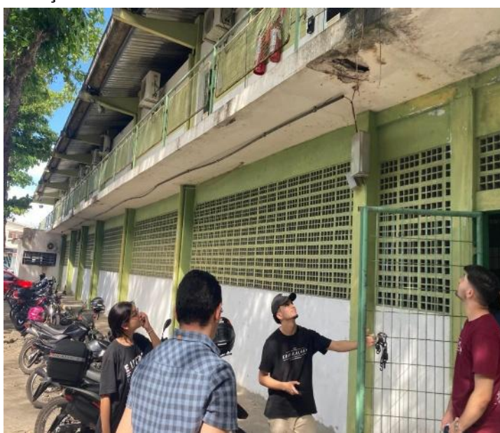
Figura 13- Apresentação de uma patologia em uma laje maciça
