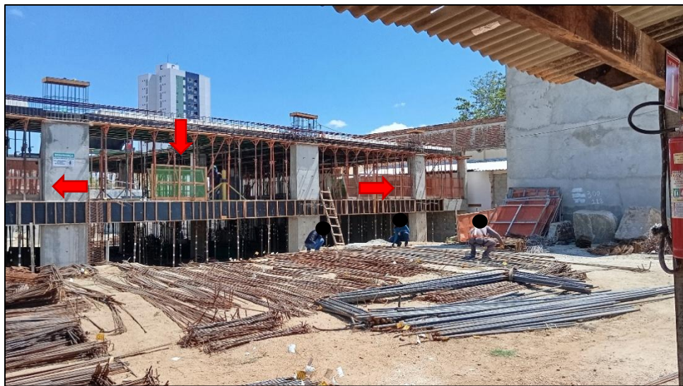
Figura 5 Instalação parcial de guarda-corpo em áreas do canteiro de obras
