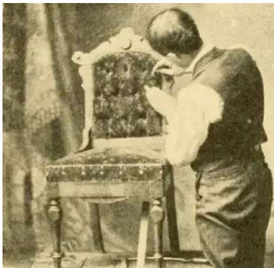
Figura 2: Produção de cadeira com técnica de estofado em capitonê
