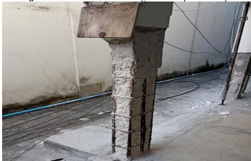
Figura 5 - Corrosão uniforme ao longo de toda superfície do aço.
