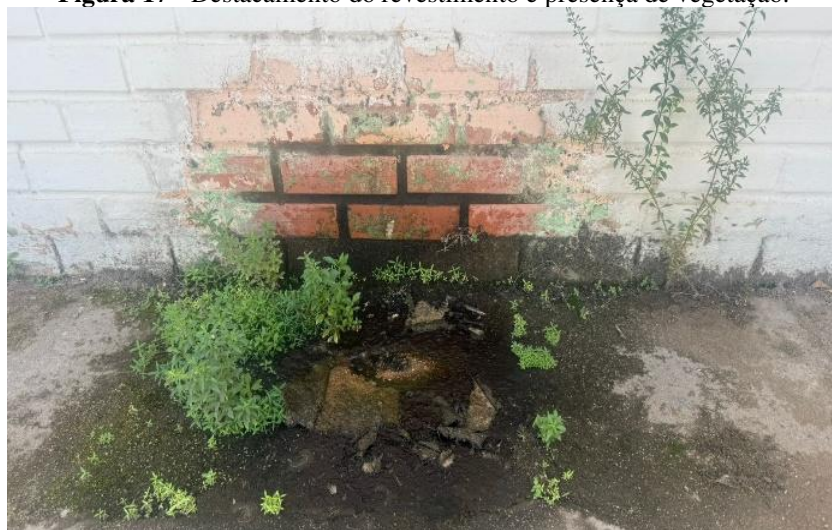
Figura 17 - Destacamento do revestimento e presença de vegetação.
