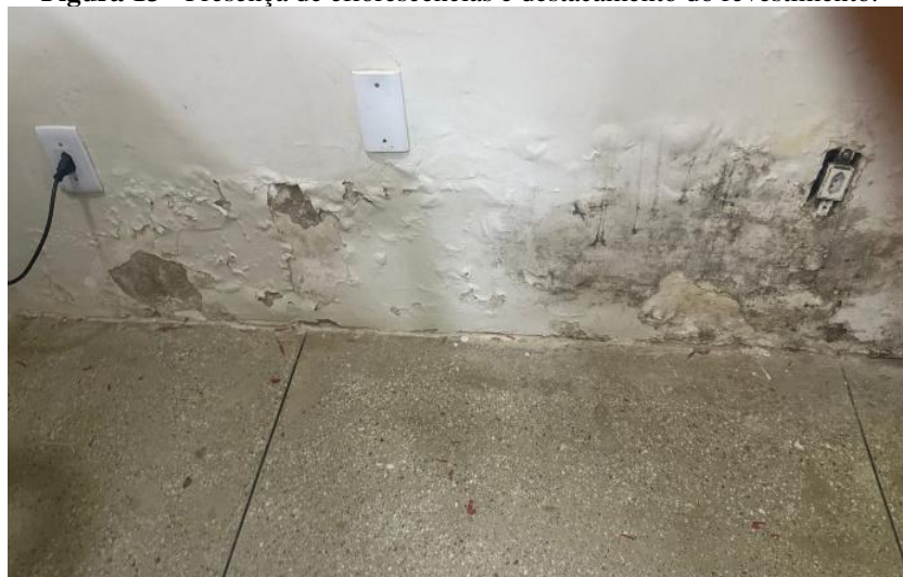
Figura 13 - Presença de eflorescências e destacamento do revestimento.
