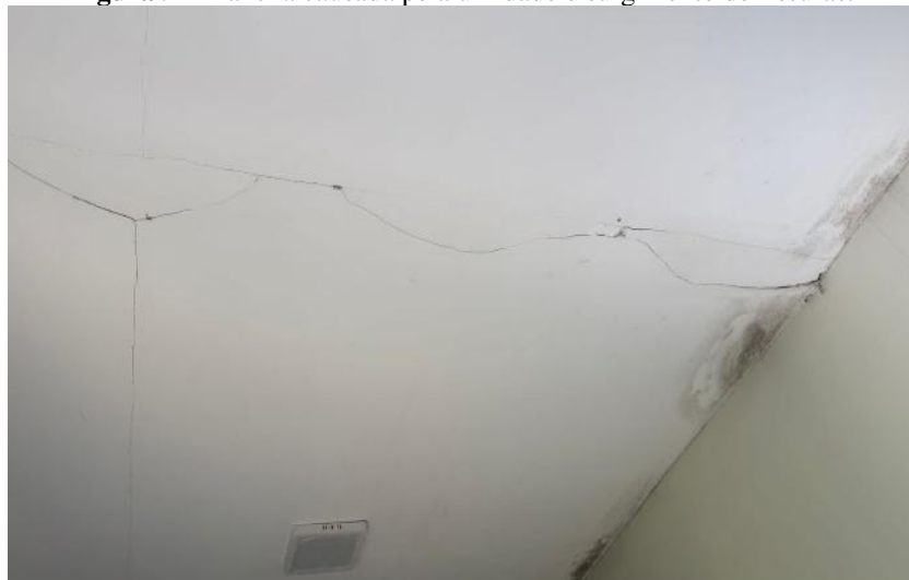
Figura 9 - Mancha causada pela umidade e surgimento de fissuras.
