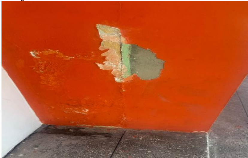
Figura 14 - Destacamento do revestimento em um banco de alvenaria.
