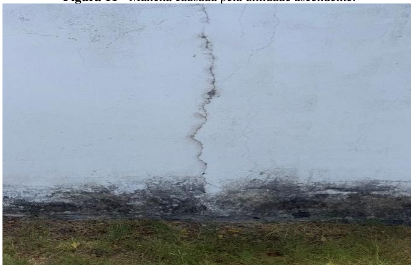
Figura 11 - Mancha causada pela umidade ascendente.
