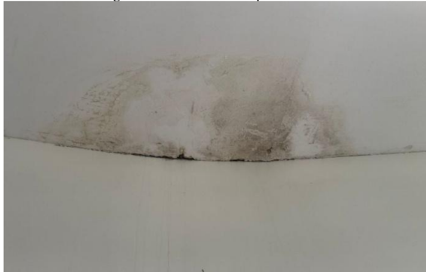
Figura 8 - Mancha causada pela umidade.
