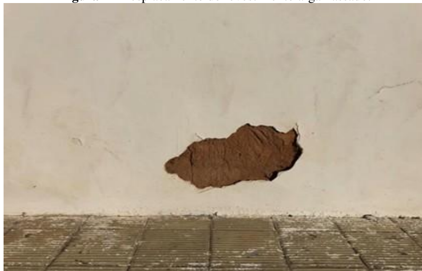
Figura 4 - Deslocamento do revestimento argamassado.
