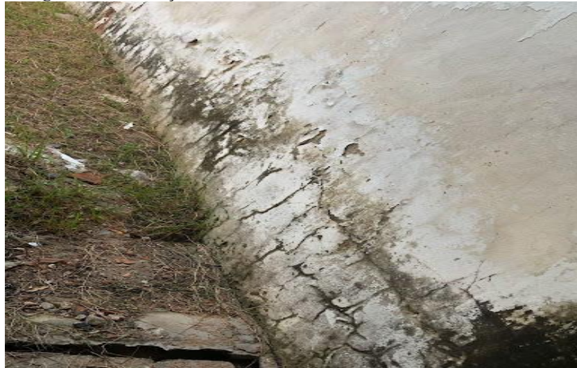
Figura 12 - Presença de eflorescências e destacamento do revestimento.
