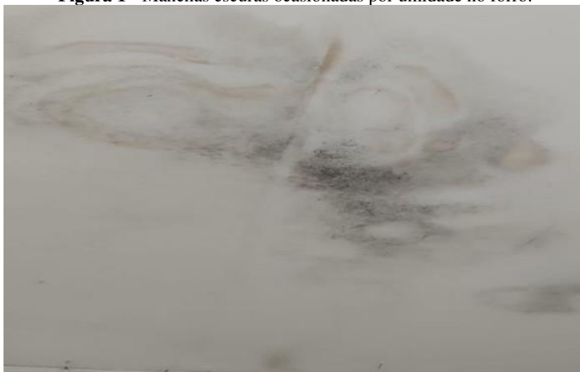
Figura 1 - Manchas escuras ocasionadas por umidade no forro.
