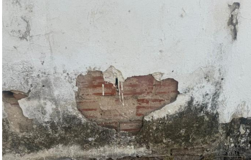
Figura 15 - Destacamento do revestimento e exposição da alvenaria.
