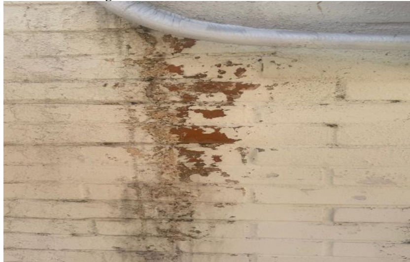
Figura 16 - Destacamento do revestimento.
