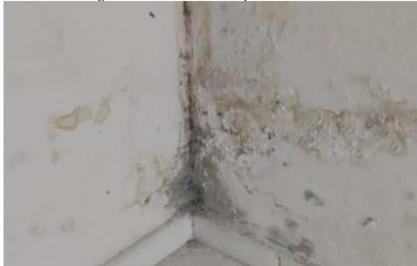
Figura 3 - Alvenaria afetada por eflorescência.
