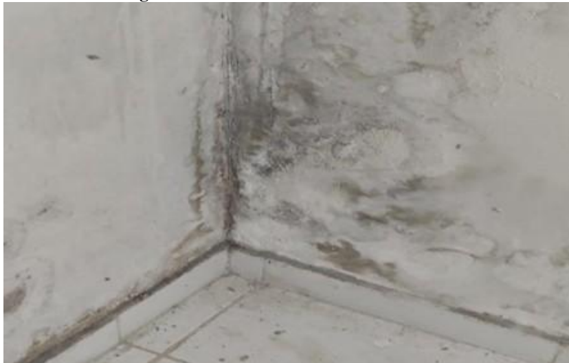
Figura 2- Foco de mofo e bolor na alvenaria.
