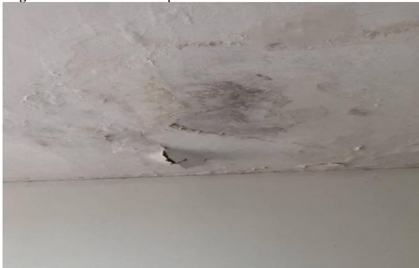
Figura 10 - Mancha causada pela umidade e destacamento do revestimento.
