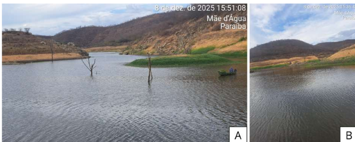
Figura 9 - Reservatório Barragem de Capoeira.
