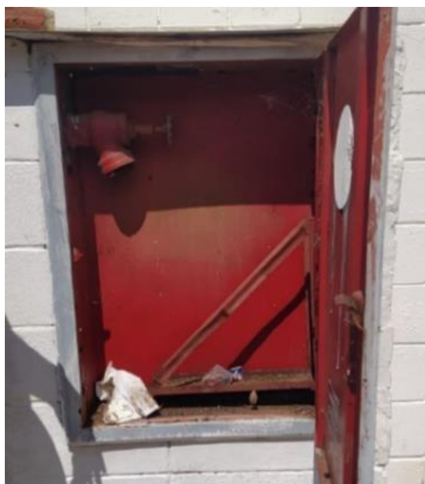
Figura 12 – Situações de não-conformidade em hidrantes: (a) uso indevido; (b) sem mangueira no abrigo.
