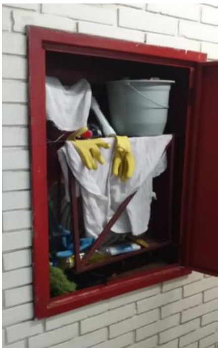
Figura 12 – Situações de não-conformidade em hidrantes: (a) uso indevido; (b) sem mangueira no abrigo.
