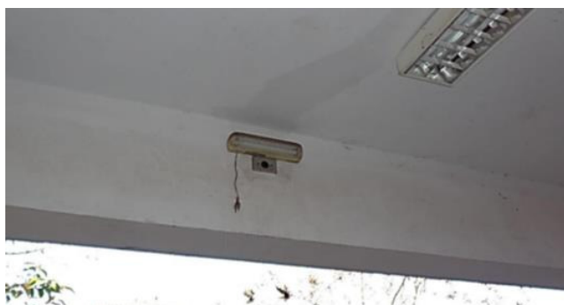
Figura 11 – Pontos de iluminação de emergência em situações de não-conformidade: (a) bloco autônomo desconectado; (b) local de bloco autônomo cujo equipamento foi retirado.
