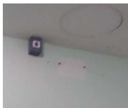
Figura 11 – Pontos de iluminação de emergência em situações de não-conformidade: (a) bloco autônomo desconectado; (b) local de bloco autônomo cujo equipamento foi retirado.
