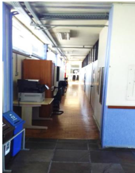
Figura 10 - Corredores obstruídos por objetos e mobiliários.
