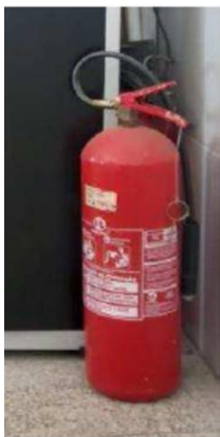
Figura 15 – Extintores sem suporte, posicionados diretamente no piso: (a) Chaves (2023); (b) Freitas (2025); (c) Covre (2023).
