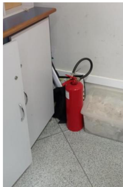
Figura 15 – Extintores sem suporte, posicionados diretamente no piso: (a) Chaves (2023); (b) Freitas (2025); (c) Covre (2023).
