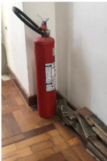
Figura 15 – Extintores sem suporte, posicionados diretamente no piso: (a) Chaves (2023); (b) Freitas (2025); (c) Covre (2023).
