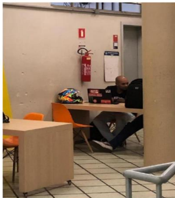
Figura 14 - Unidades extintoras obstruídas: (a) Melo Neto, Borges e Pereira (2021); (b) Freitas (2025).
