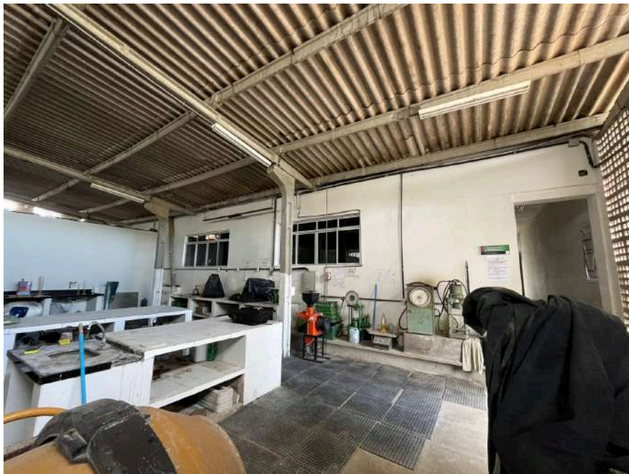
Figura 9 - Elemento estrutural estudado
