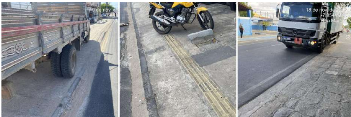
Figura 22 – Veículos estacionados sobre a calçada
