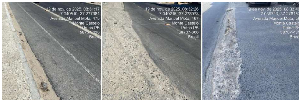
Figura 19 – Borda da calçada no mesmo nível da faixa de rolamento
