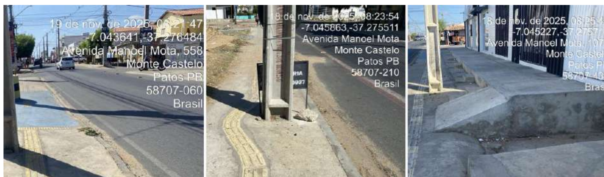
Figura 18 – Piso tátil mal posicionado
