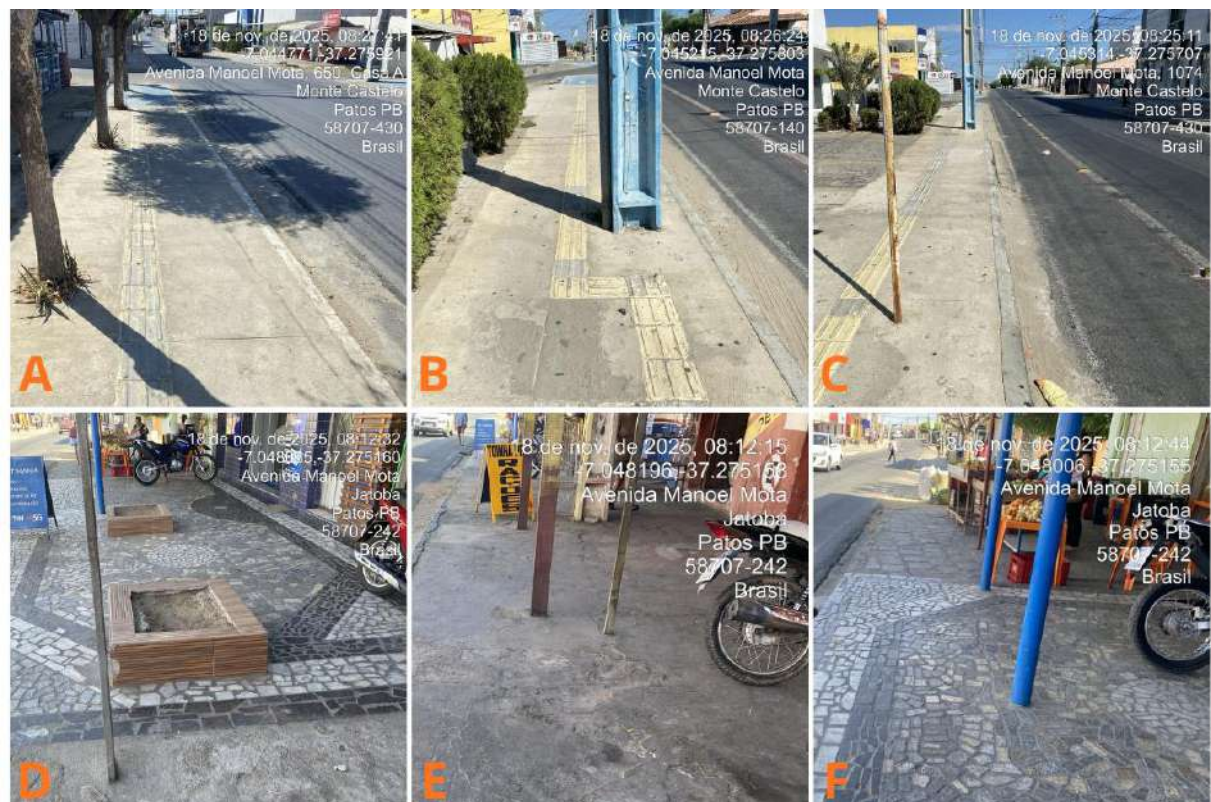
Figura 15– Obstrução nas calçadas dos trechos 3 e 4: (A, B e C) Trecho 3; (D, E e F) Trecho 4
