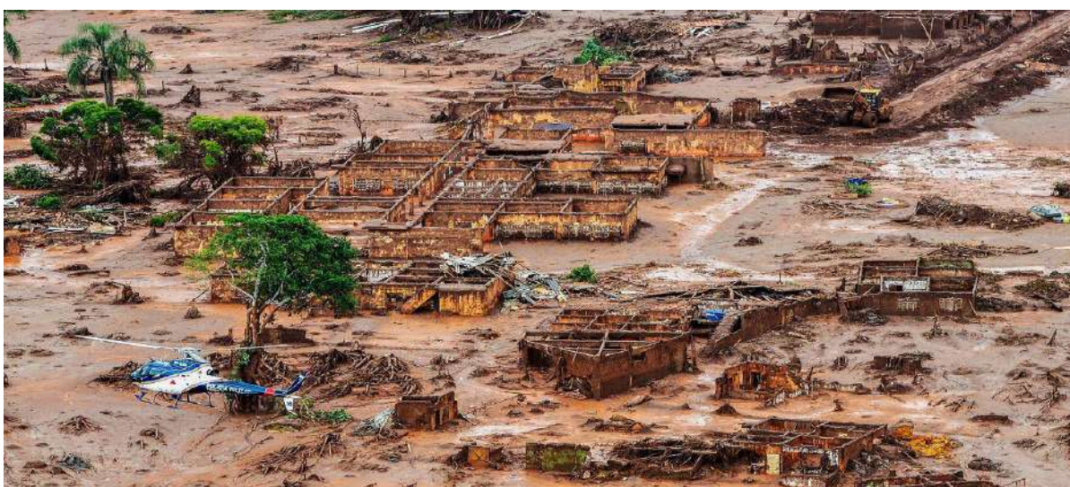
Figura 1 – Impactos do rompimento da barragem em Brumadinho (MG)
