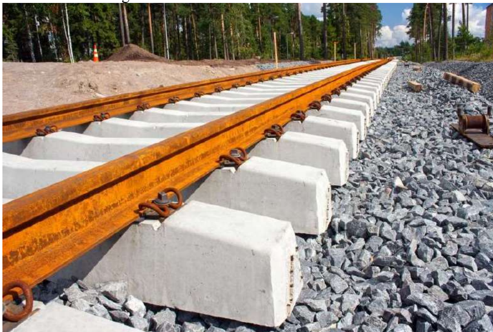
Figura 6 – Dormentes ferroviário de concreto
