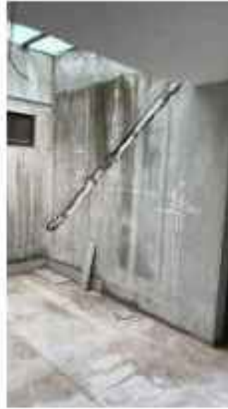
Figura 5 - Cortes na parede para a passagem de ponto de ar-condicionado
