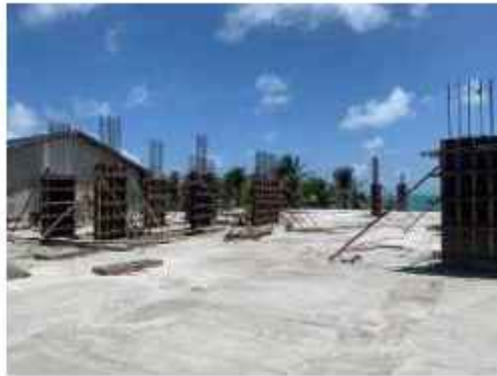
Figura 3 - Execução da atividade de superestrutura
