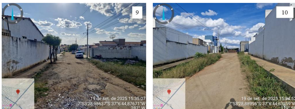
Figura 9 – Rua José Francisco Bezerra (9 – vista sentido oeste, 10 – vista sentido leste)
