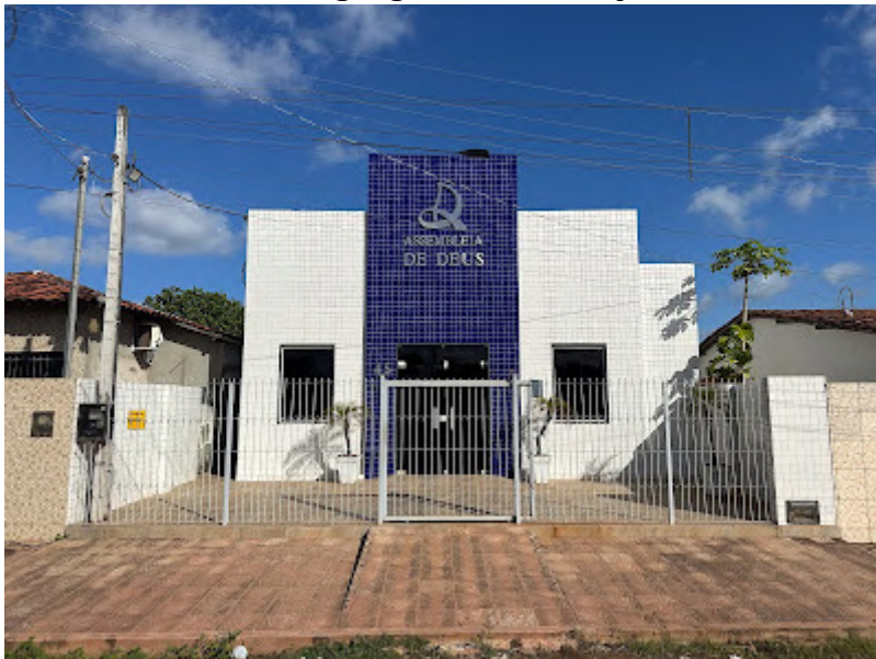
Foto 5 - Fachada da Congregação do Conjunto dos Motoristas
