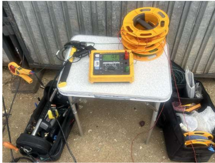
Figura 16: Medição de resistência de aterramento no Camarote B.
