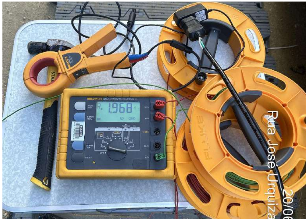
Figura 11: Medição da Segunda Resistência de Aterramento do Palco.
