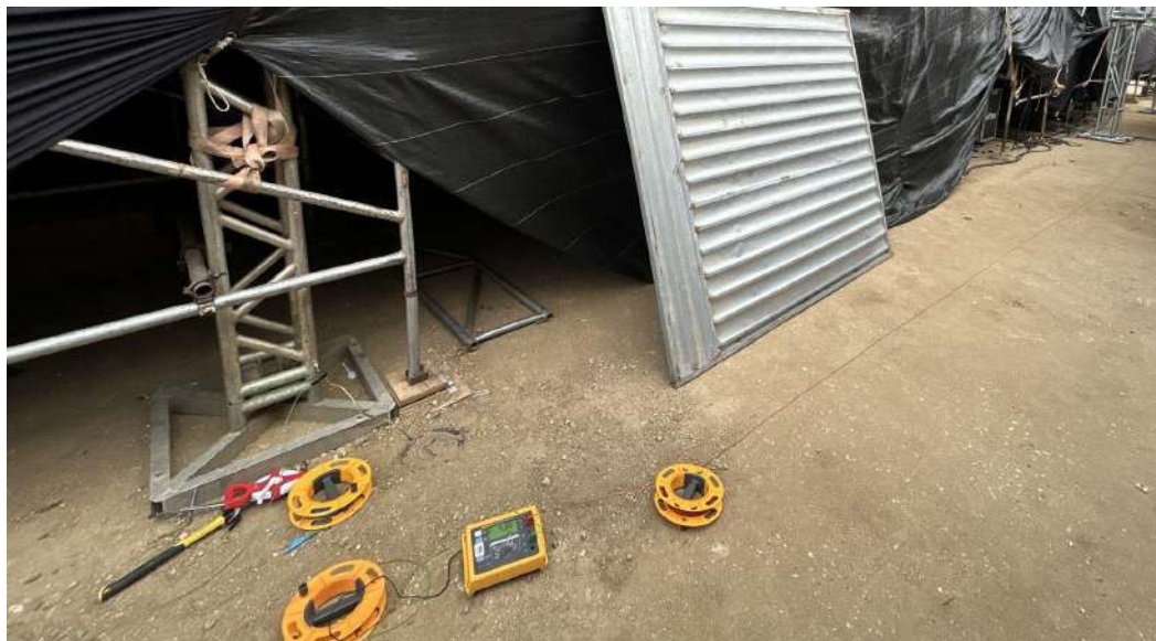
Figura 13: Medição de Continuidade.
