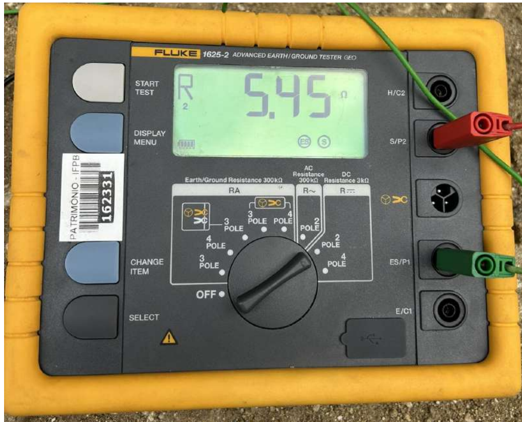
Figura 14: Medição da resistência do cabo e da estrutura.
