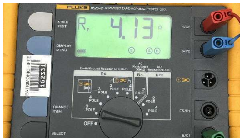
Figura 10: Medição da Primeira Resistência de Aterramento do Palco.
