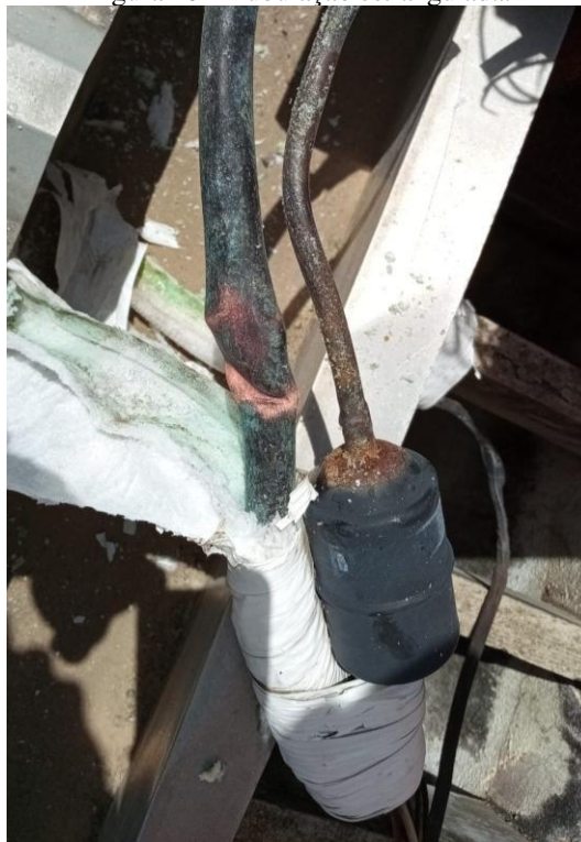
Figura 20 – Tubulação estrangulada.
