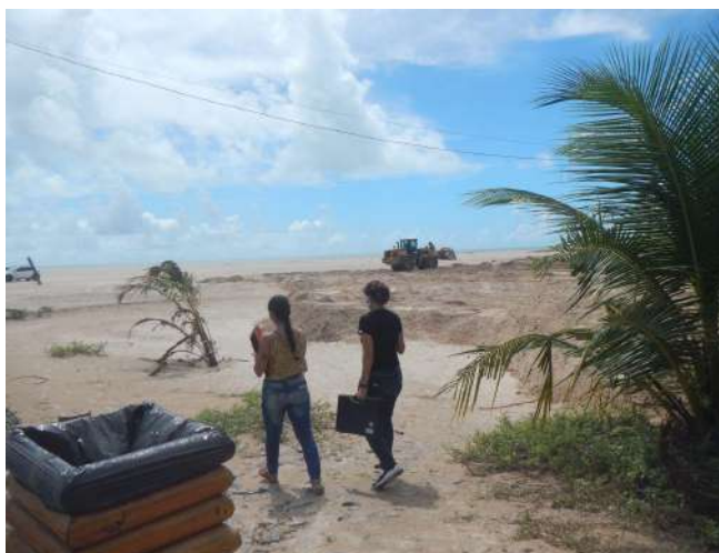
Figura 6: Ocorrência da terraplanagem do terreno.
