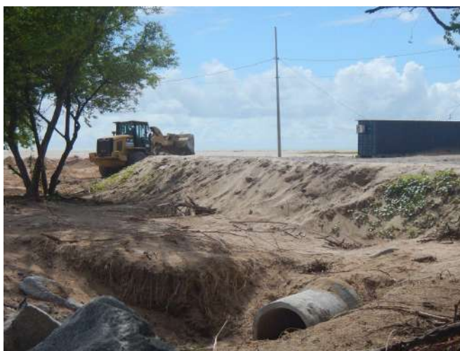
Figura 5: Retirada da vegetação para construção da pista de acesso ao Dique.
