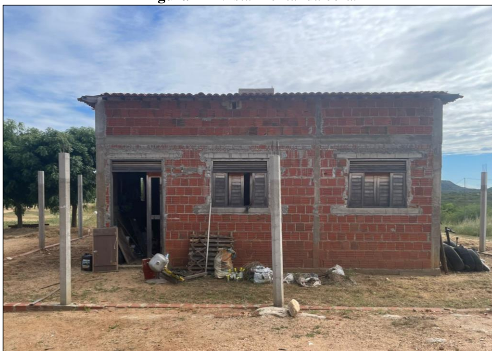
Figura 2 – Vista Frontal da obra.
