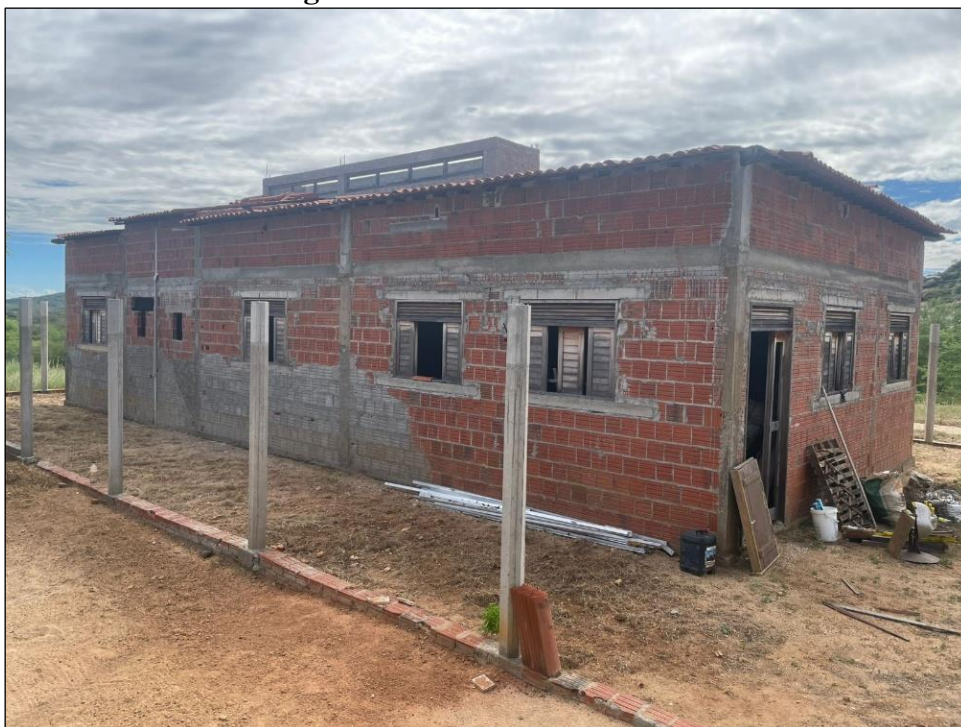
Figura 3 – Vista Lateral da obra.
