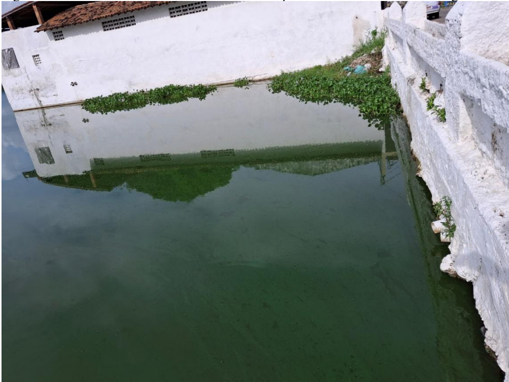
Figura 15 – Ponto de descarte de resíduos sólidos e possível saída de efluente de esgoto.
