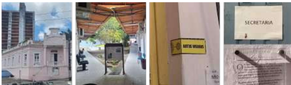
Figura 128 - Problemas identificados no local.
