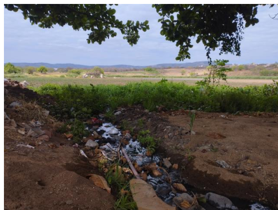
Figura 6 - Em destaque, o rebaixamento do nível de sangria do Açude Padre Ibiapina, possivelmente realizado para ampliar a área de construção de residências na área de APP do Açude Padre Ibiapina
