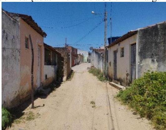
Figura 23 - Ruas estreitas e residências com calçadas inferiores a 50 cm de largura
