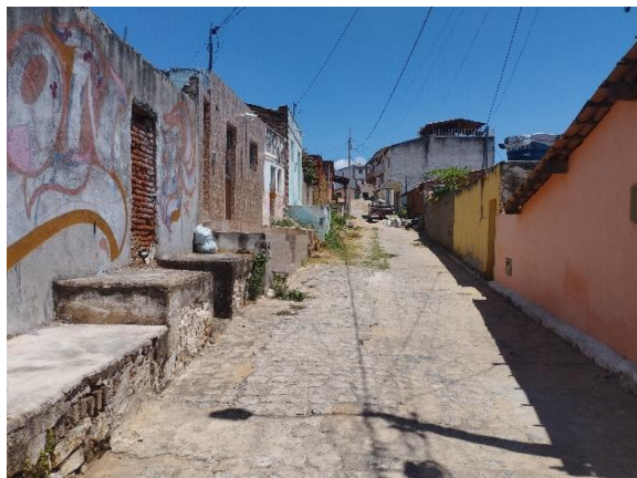
Figura 21- Calçadas descontínuas e via pública com iluminação pública insuficiente
