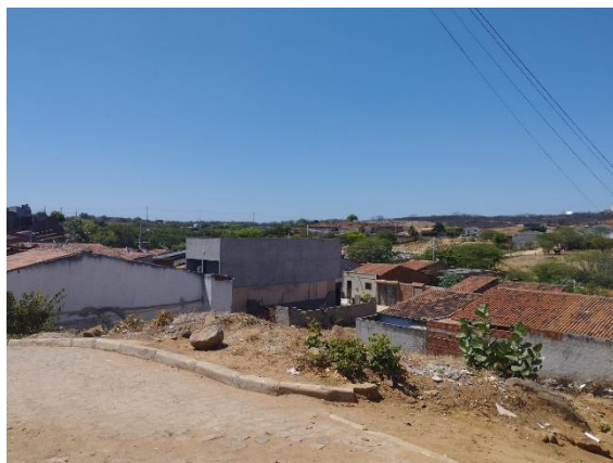
Figura 15 - Na parte superior, o Açude Padre Ibiapina; na parte inferior, construções abaixo do nível da barragem.
