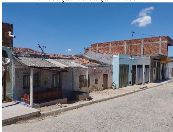
Figura 18 - Casas estreitas e rebaixadas em relação ao nível da via, após a execução de calçamento.
