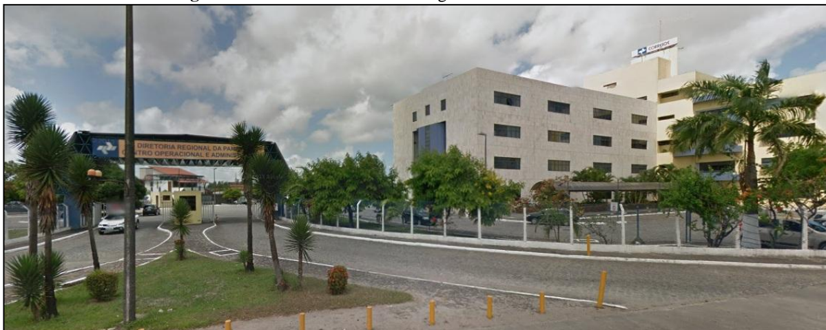
Figura 3 – Fachada da Diretoria Regional dos Correios da Paraíba
