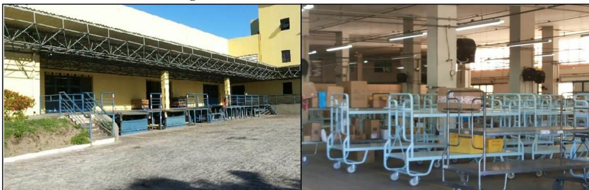
Figura 7 – Fachada e Parte Interna do CEE-JP
