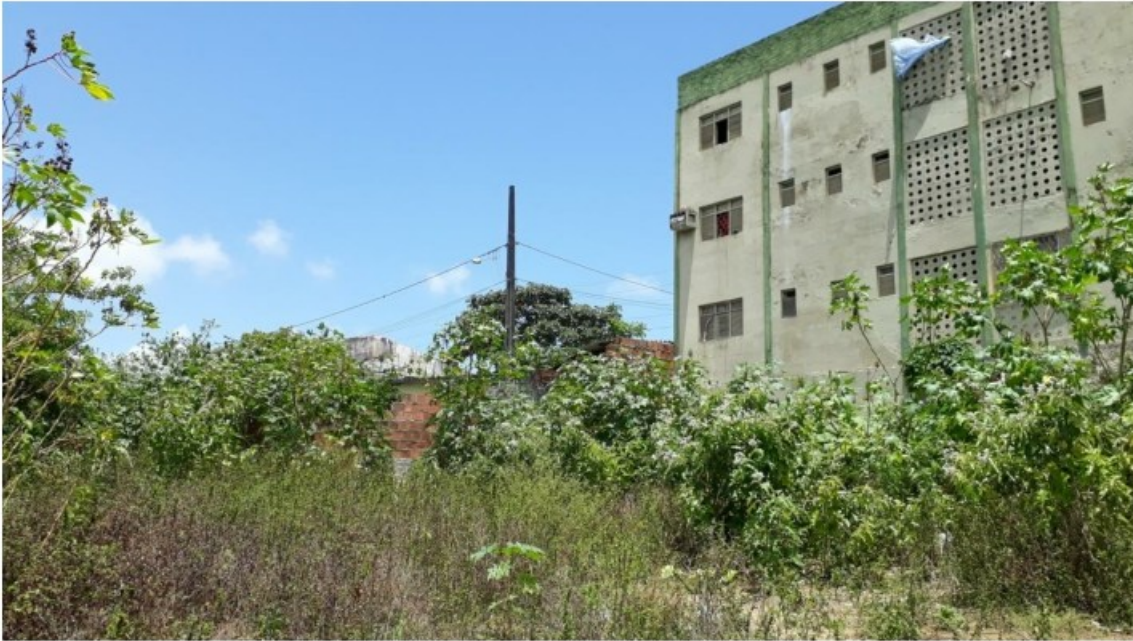
Figura 04 – Falta de Limitação Perimetral
